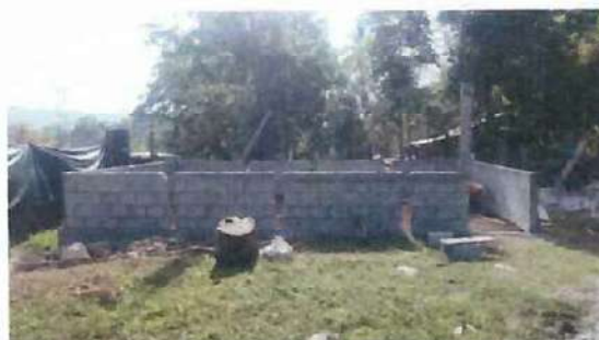
Foto 4: culminacion de colocacion de block
