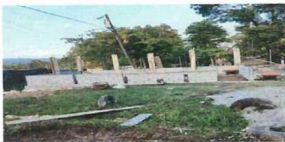
Foto 5: fundicion de columnas.
