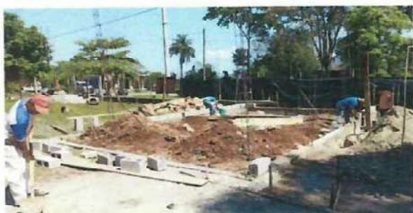
Foto1: El cimiento de la obra realizado por los miembros de la comunidad
