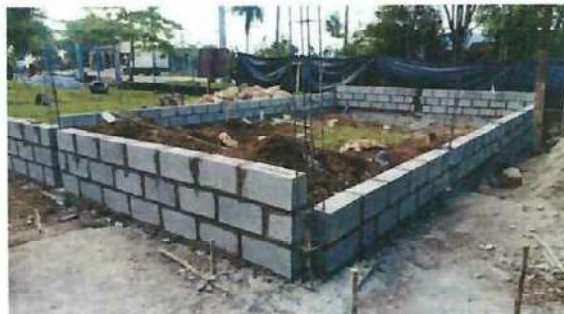
Foto 2: colocacion de block
