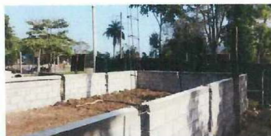
Foto 6: El relleno dentro de la construcción.
