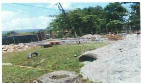
Foto 3: Inicio de colocacion de blok para la cocina
